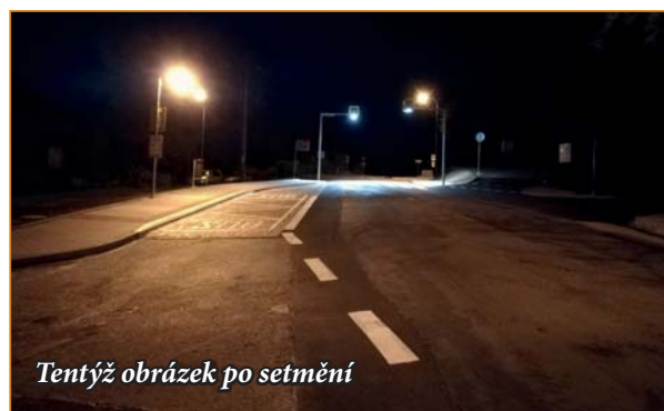
Nové zastávky s přechodem na Oulehle
